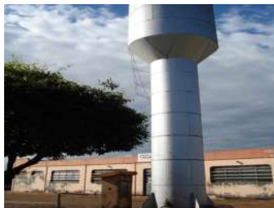
Central de distribuição da Escola 3
