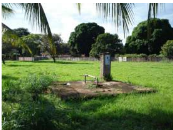
Poço artesiano C
