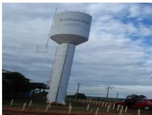
Central de distribuição da Escola 1
