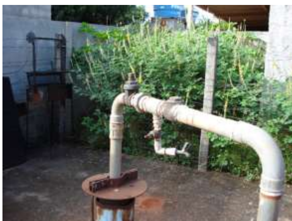
Poço artesiano B
