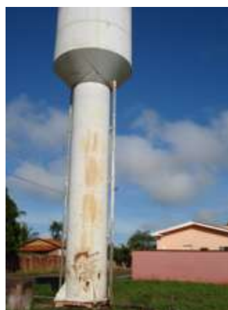
Central de distribuição da Escola 2
